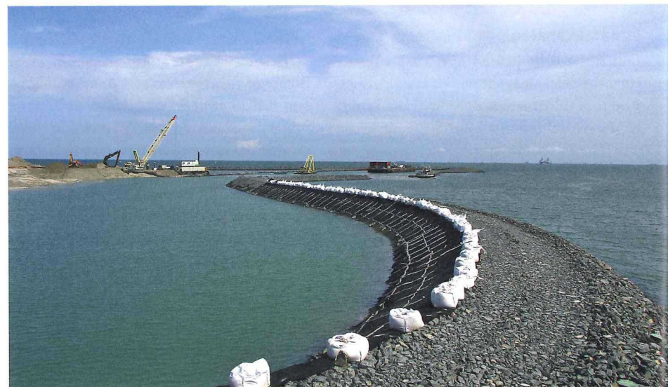
Den stenlagda formen som kommer att utgöra grunden för den andra lyxön.
