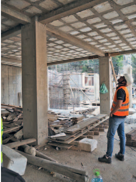
Skeptiska blickar vandrar över ytorna på byggarbetsplatsen i La Paz.
