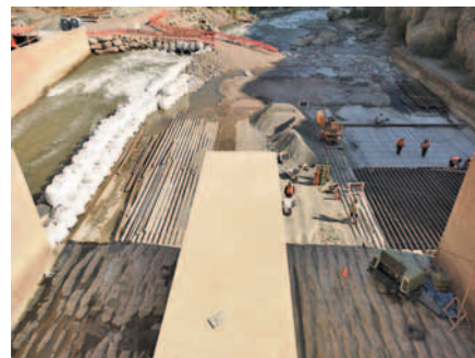
Renovering av nivåreglerande dam i anslutning till Cheves hydro power plant.
