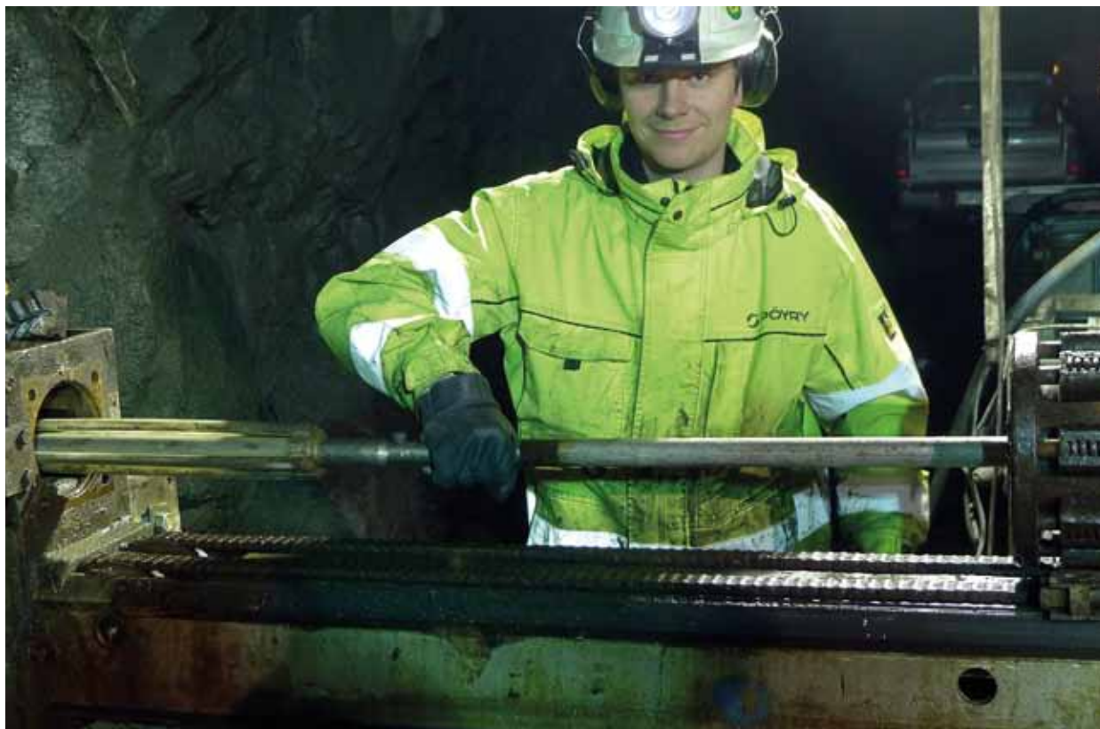
Bergspänningsmätning med överborrningsmetoden. Bilden visar installation av dummy som kontrollerar att pilothålet är okej.
