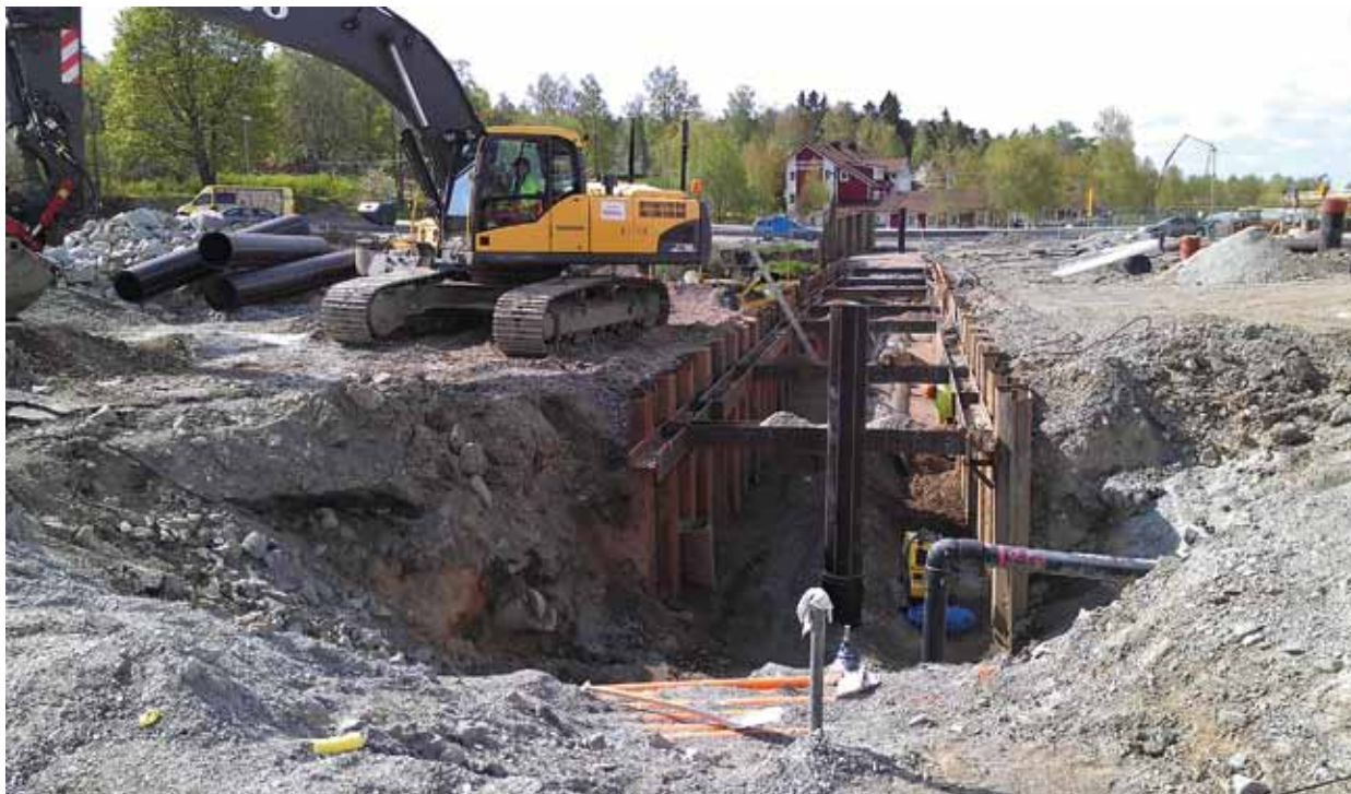
Spont vid schakt för va-ledningar.
