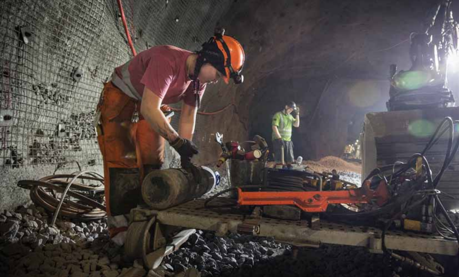
Johan Magnusson, maskinförare på Klemo Data, och Jenny Söderberg, svetsare från Infranord, arbetar med de två sista skarvarna av 1,5 års arbete.
