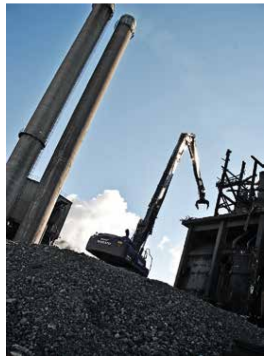
Höjdrivaren når 30 meter upp i luften och kan plocka pinne för pinne från träöverdelen på släcktorner
