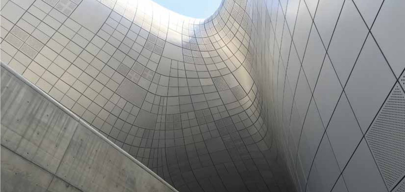
Dongdaemun Design Plaza i Seoul har en fasad av precisionsskurna dubbelkurvade stålplattor.
