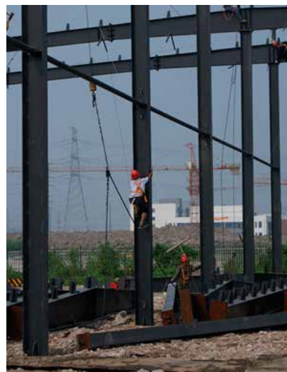
En kinesisk byggnadsarbetare tar sig utan fallskydd upp för en vertikalbalk. Nedanför honom skymtar grundläggningmaterialet som består av byggavfall.
