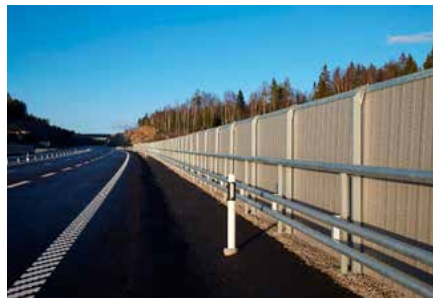
Praktisk och smart montage som kompletterar sidoräcket och ger en bullersänkning från biltrafiken till omgivningen av den nya E4:an vid Sundsvall.
