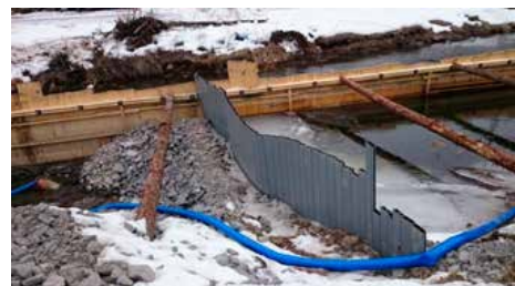
Fördämning av Gusumån vid saneringsarbete.
