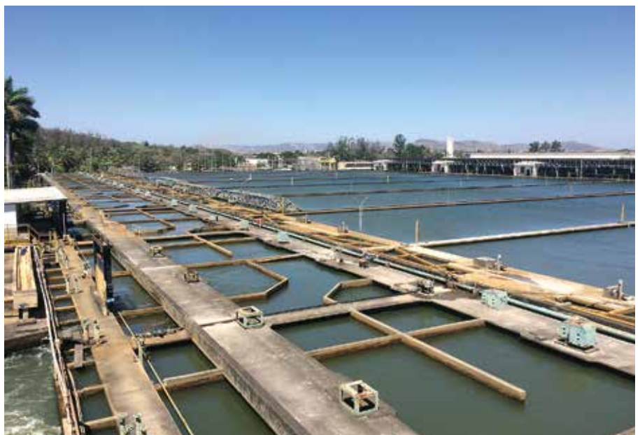
Vattenverket vid Guandu är ett av världens största och levererar vatten till 9 miljoner invånare i Rio.
